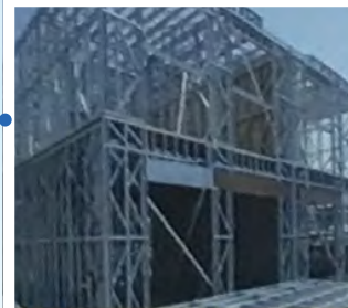
・メインフレーム工事
