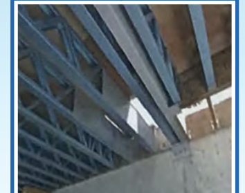
・フロアデッキ工事
