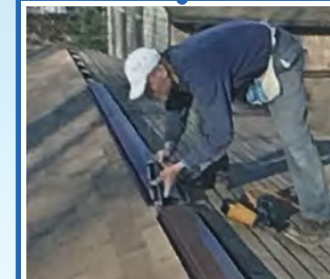
・屋根フレーム工事
